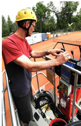
Abbau der alten Leuchten in 12 Meter Höhe
