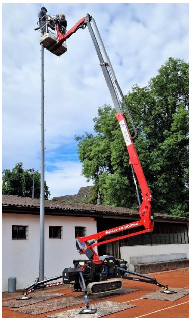
Abbau der alten Leuchten in 12 Meter Höhe
