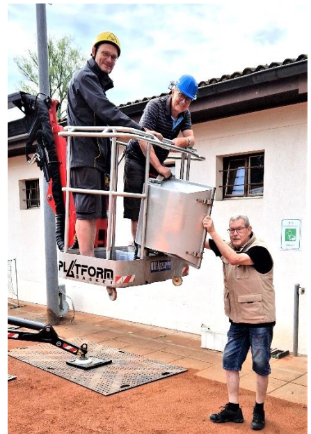
Abbau der alten Leuchten in 12 Meter Höhe
